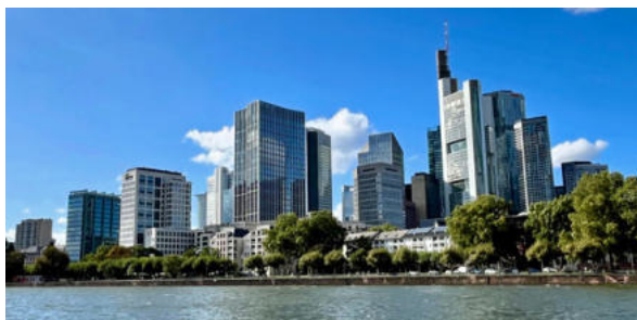
Blick vom „Eisernen Steg“ auf die Skyline
