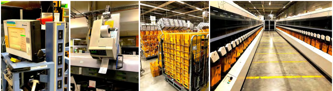
Kontroll- und Zählleinheit
